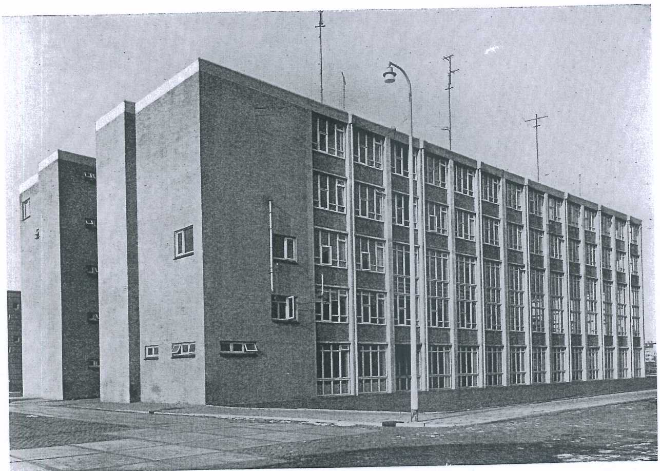
Telecommunicatiegebouw van Van der Heem N.V. te Den Haag
